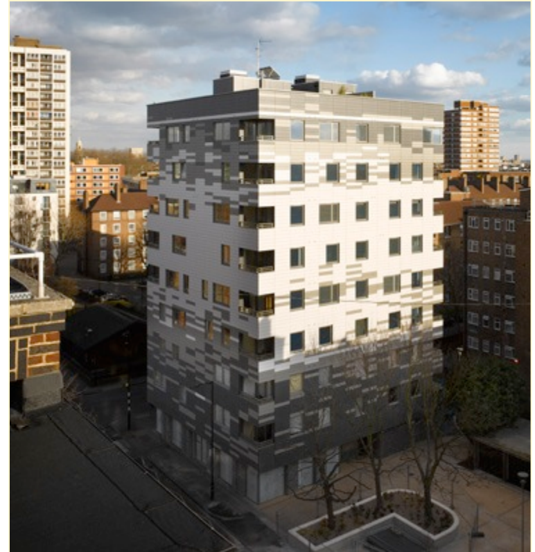
Murray Grove Building, Londres, GB Premier étage béton et 8 étages CLT
